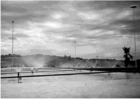
圖2-9聯邦大廈屋頂灑水降溫系統照片
