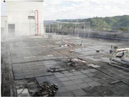
圖 3-14 屋頂剝落毀損的隔熱磚重整圖
