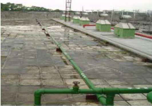
圖2-7義守大學頂樓降溫灑水系統照片
