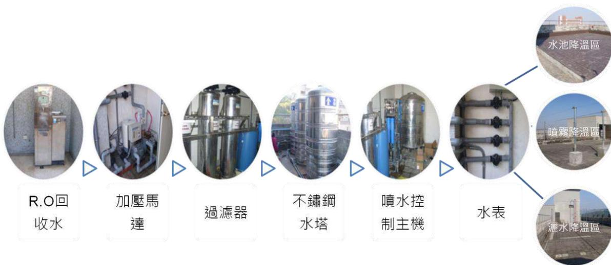
圖3-9屋頂降溫系統RO回收水流程圖(資料來源:本研究繪製)
