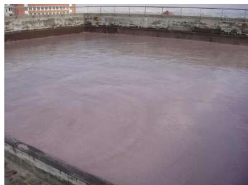
圖 3-11 防水層施工後照片
